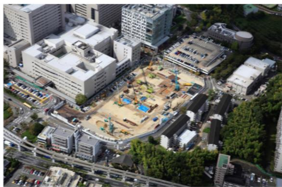
2021年 工事現場航空写真
