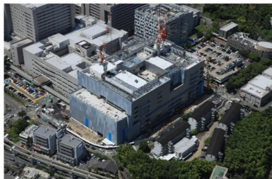
2024年 工事現場航空写真
