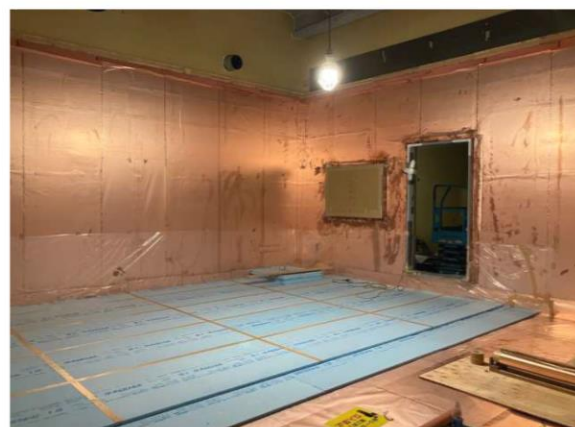
2024年8月 B1階 MRI壁工事
