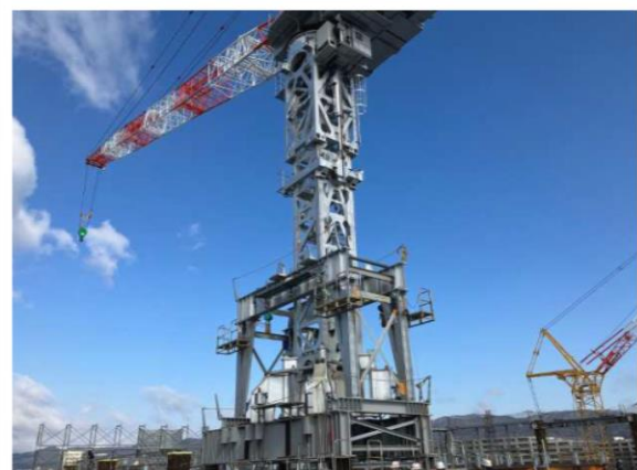
2024年3月 工事用タワークレーンクライミング風景
