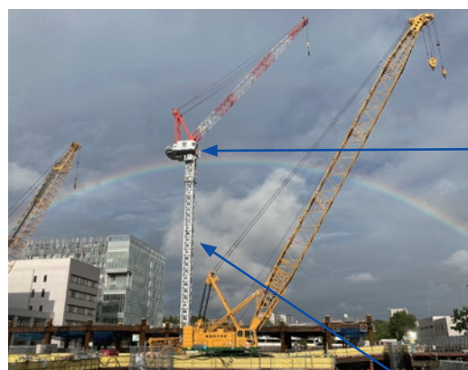
タワークレーン
