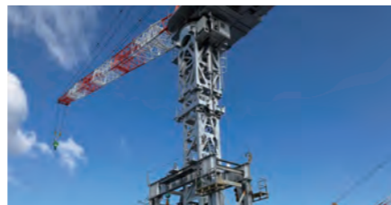
▲2024年3月 工事用タワークレーンクライミング風景
