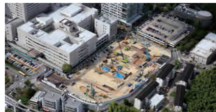
▲2021年 工事現場航空写真
