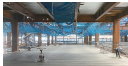
▲2024年4月 6階 スラブコンクリート打設完了
