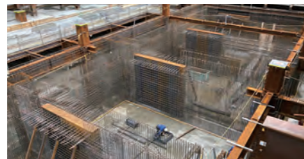
▲2023年6月 B2階 リニアック躯体施工状況
