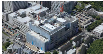
▲2024年 工事現場航空写真
