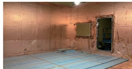
▲2024年8月 B1階 MRI壁工事
