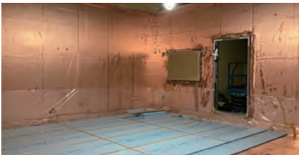
▲2024年8月 B1階 MRI壁工事
