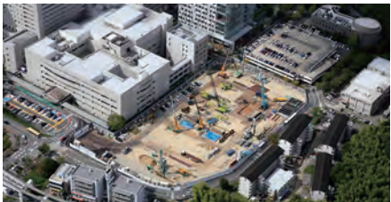
▲2021年 工事現場航空写真
