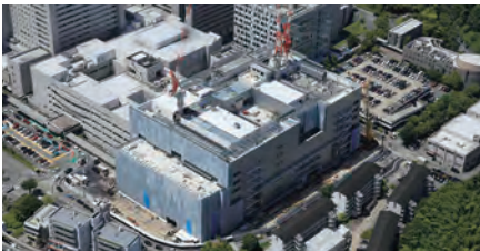
▲2024年 工事現場航空写真
