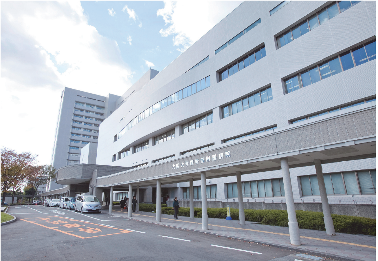
正面玄関外観
