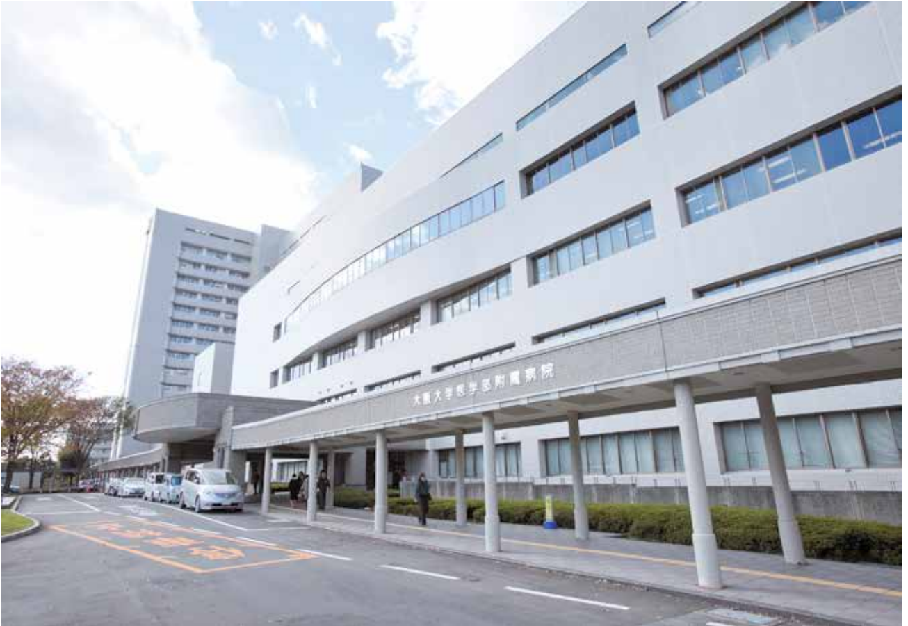
正面玄関外観
